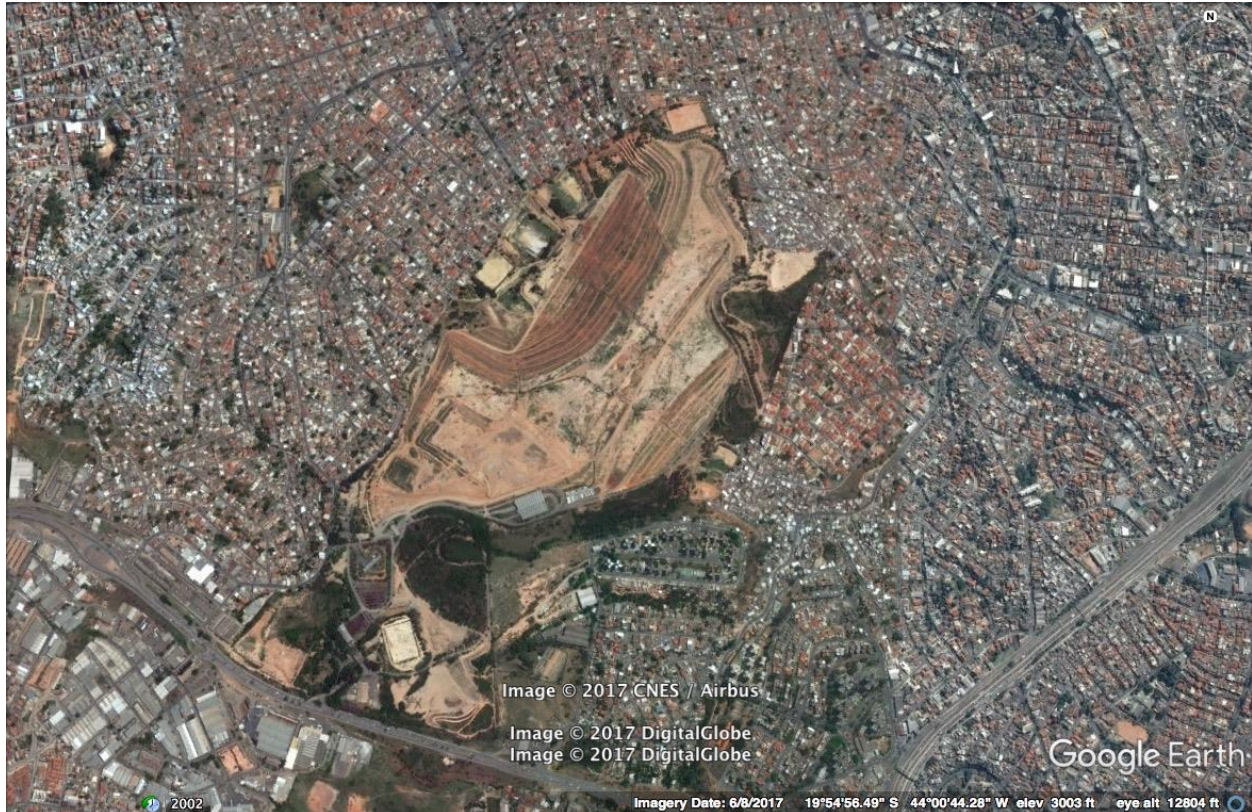
Figure 3: Aerial view of the Centro de Tratamento de Resíduos Sólidos in Belo Horizonte, Brazil.
